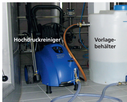
Anwendung von pH-neutralen Reinigungsmitteln mittels Hochdruckreiniger
