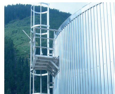
Leiter mit Dachzugang
