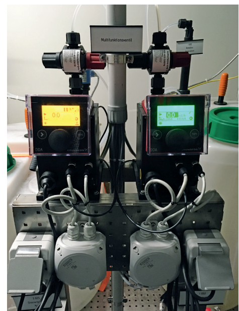
Vollautomatische Dosierung Natronlauge und Anti-Scalant
