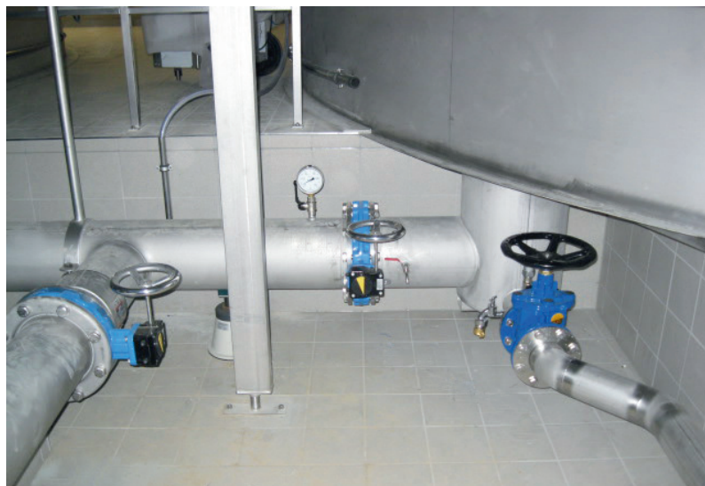
Bild 4. Grundablass mit Entnahmetopf.
