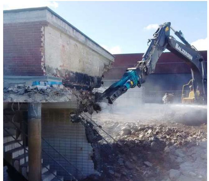
Bild 5: Rückbau Behälteranlage
