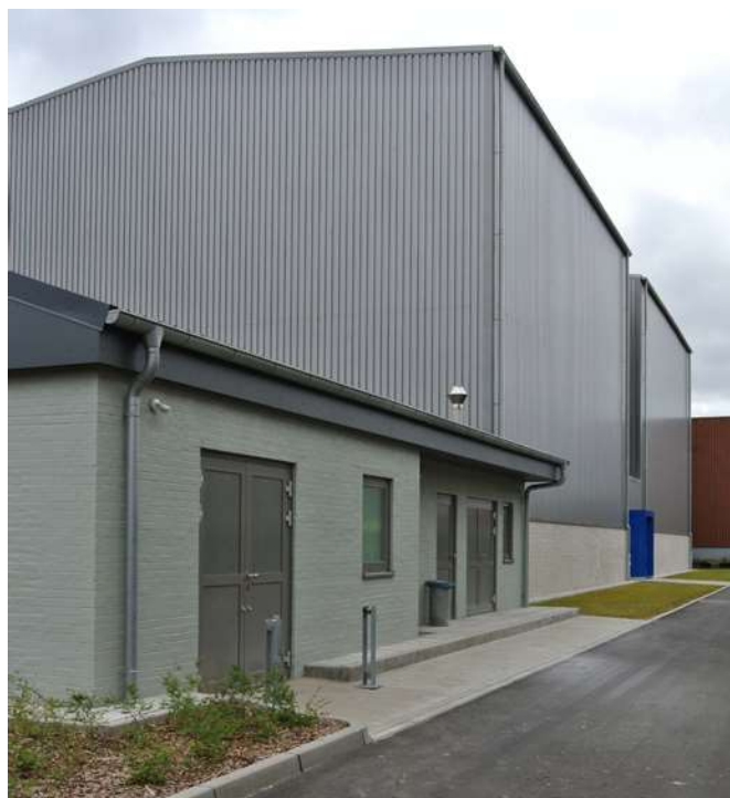
Bild 1: Anlage nach Fertigstellung
