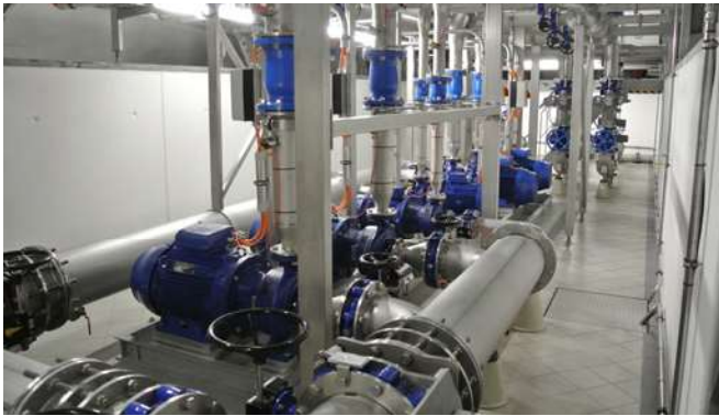
Bild 7: Druckerhöhungsanlagen
