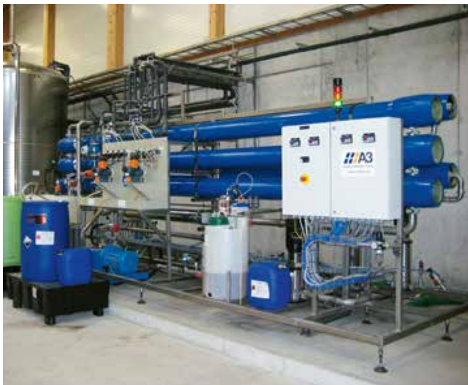
▲ Permeatgestufte Umkehrosмосanlage.
