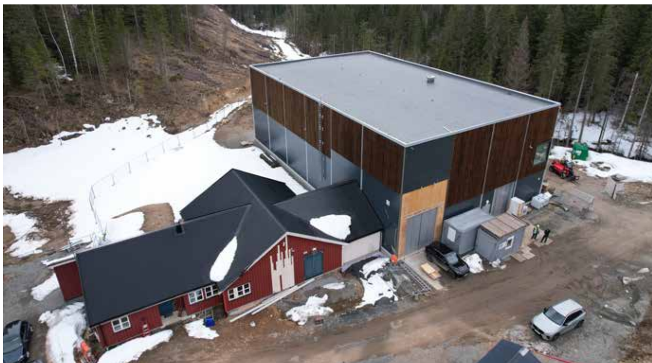
Det nye ozonering-biofiltreringsanlegget på 900 m 2 ligger flott plassert i terrenget i nærheten av råvannskilden Tisjøen. Deler av det gamle vannverket til venstre vil fortsatt være i bruk. Det nye anlegget har en total investeringskostnad på 100 millioner kr. Foto: Kjell M. Jacobsen
