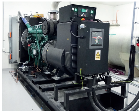
Luftgekühltes Notstromaggregat
