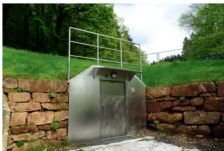
Zugang zum Pumpwerk
