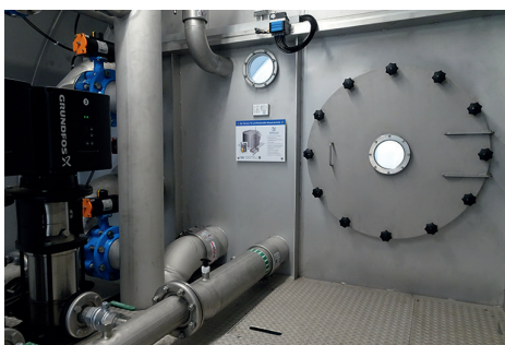
Zugang zum Quellsammelschacht
