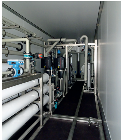
Vormontage im Werk
