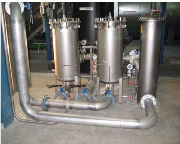
Vorfiltration über Kerzenfilter
