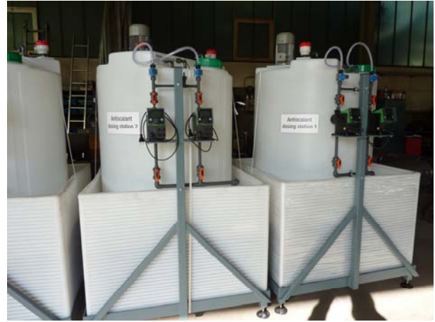
Dosierstation für Antiscalant
